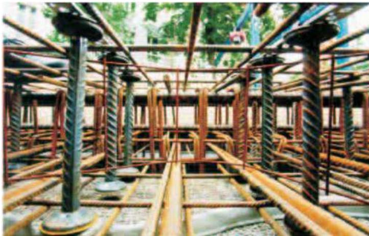
*Bild 2.8:* Doppelkopfanker als Platten-Querkraftbewehrung; Quelle: [2.9]
